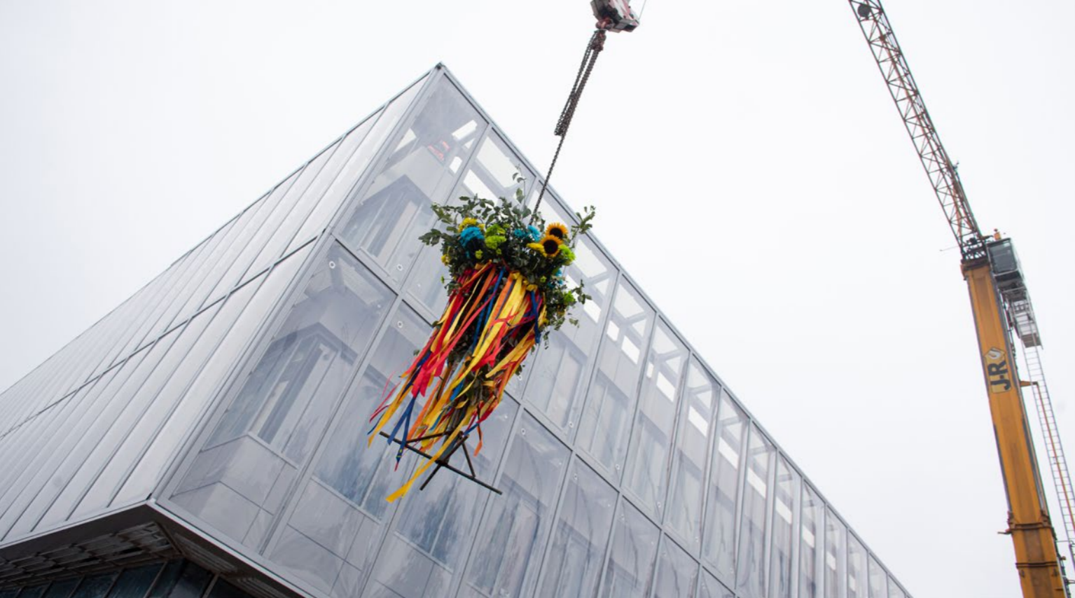
Zakończyliśmy prace konstrukcyjne na budowie Pracowni Przewrotu Kopernikańskiego
